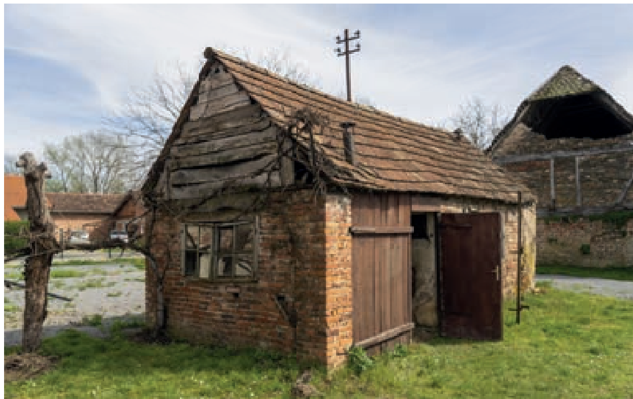
ЈАСЕНОВАЦ, МОНАСТИРСКО ИМАЊЕ, ЗГРАДА ТЗВ. УСТАШКЕ БОЛНИЦЕ
